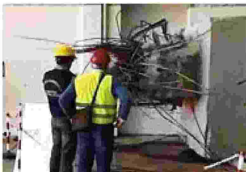
La prova I tecnici davanti al reperto 132, il tirante strappato
